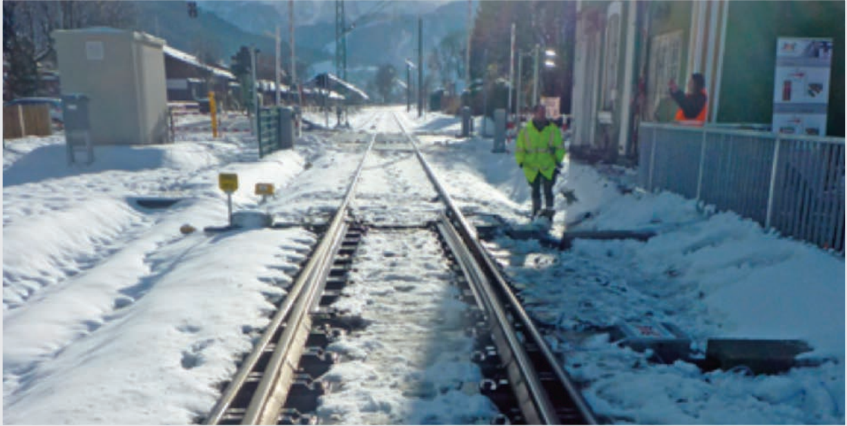
geoKOAX-Sonden sorgen klimaneutral für eis- und schneefreie Weichen. (Foto: TripleS GmbH)
