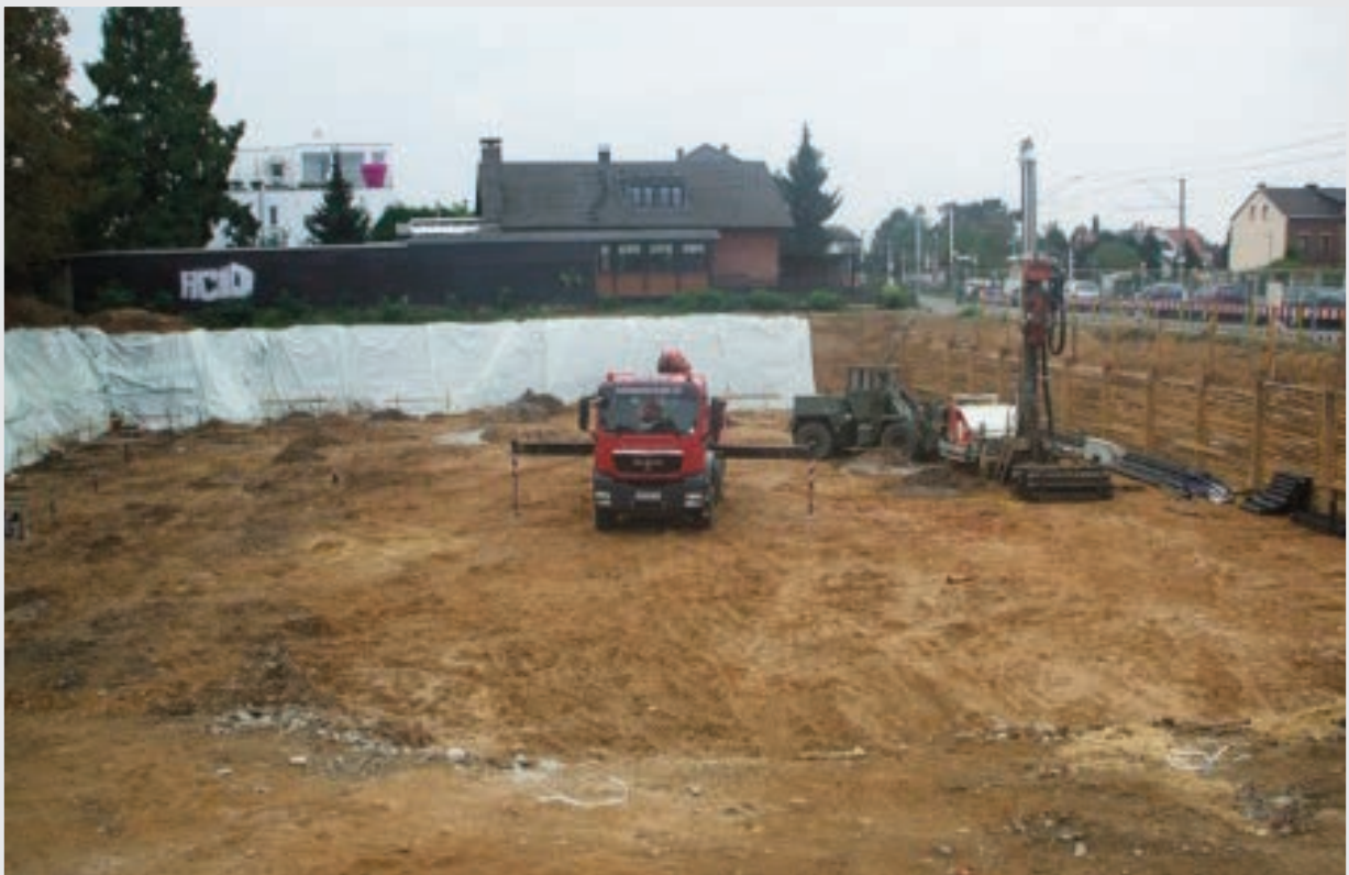
Teufen der geoKOAX-Sonden unter dem Gebäude.
