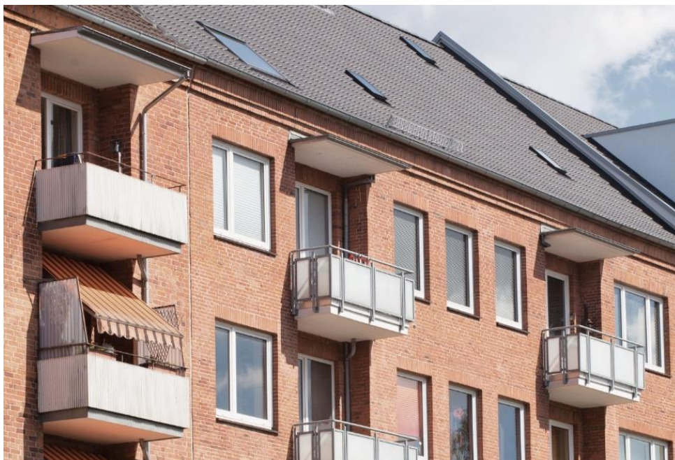
Der Altbau aus dem Jahr 1965 wurde kernsaniert und energetisch optimiert.
